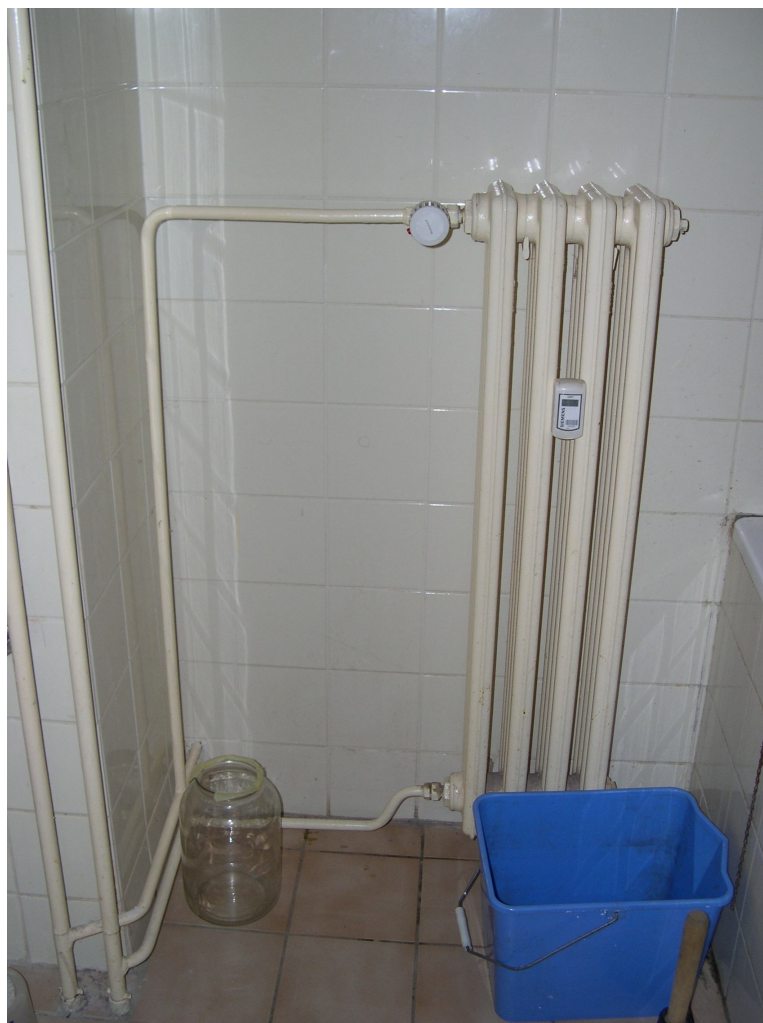
žebrový ocelový radiátor vedle vany
