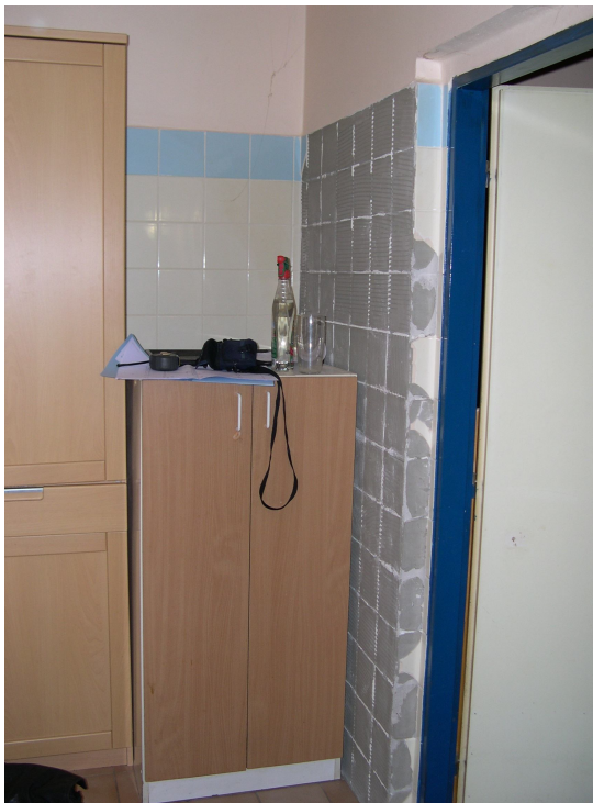
odstraněný keramický obklad vedle vstupních dveří do sociálního zařízení
