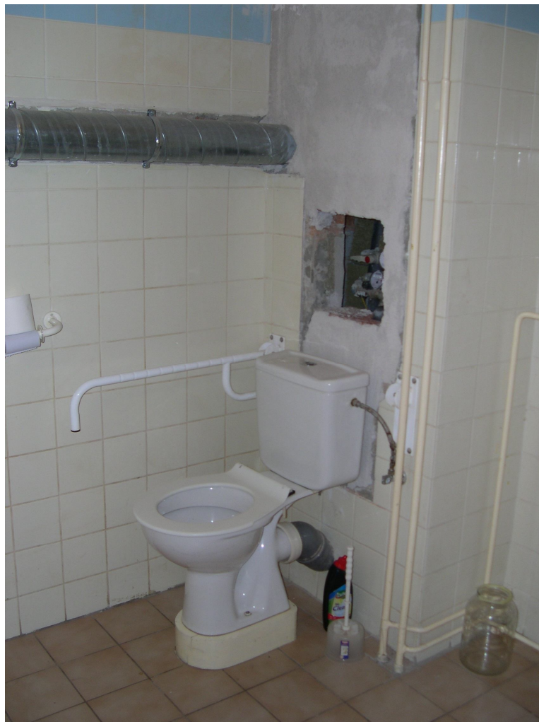
pohled na klozet s madly, revizní otvor, VZT potrubí vedené po povrchu
