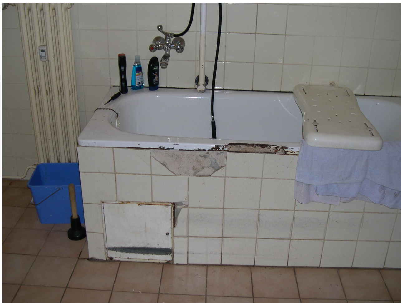
stávající stav vany, madla a revizních dvířek
