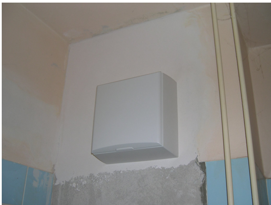
VZT zařízení na stěně za klozetem
