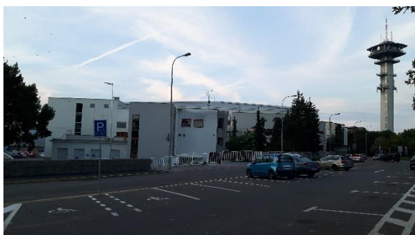
Foto 3: Multifunkční hala, pohled od S, vlevo trafostanice a rozvodna
